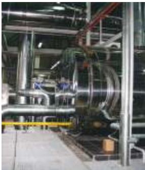
Abb. 3: Spitzenlastkessel
